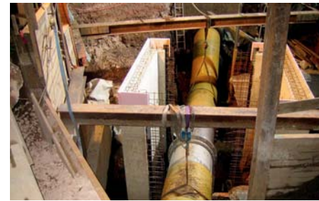
Abdichten der Dükerleitung am Betonrohr
