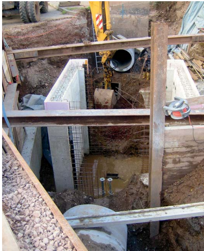
Installation des Messschachts zwischen der aufgetrennten Betonrohrleitung
