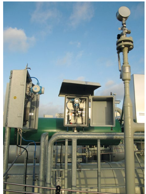
Bild 3. Druck-/Differenzdruckmessungen CERABAR S / DELTABAR S im Messumformerschutzkasten.
