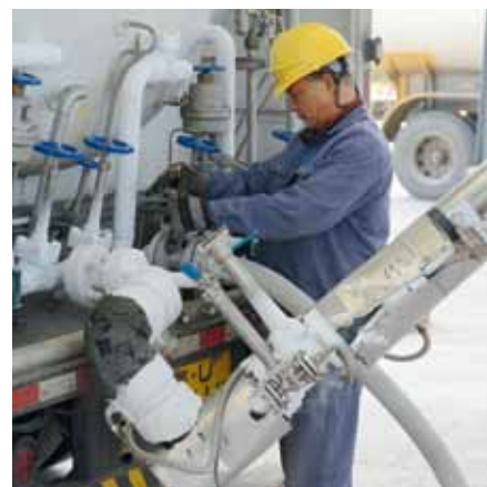
Vielseitiges System: Am Lkw-Terminal in Yan'an wird Erdgas verladen, das bei -162 °C verflüssigt wurde.
