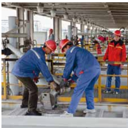
Effizienter Betrieb: Bis zu 40 Tanklastwagen können am Terminal in Panjin gleichzeitig mit Diesel befüllt werden.
