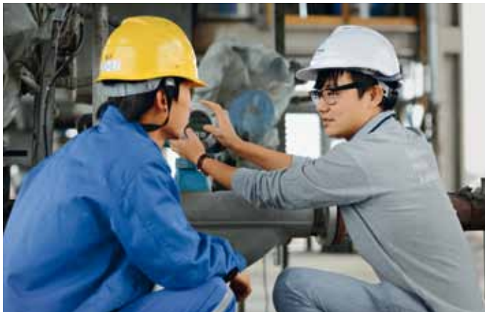
Kundennähe: Projekt-Ingenieur Song Zhaoming (rechts) überprüft mit einem Raffineriearbeiter ein Durchflussmessgerät.
