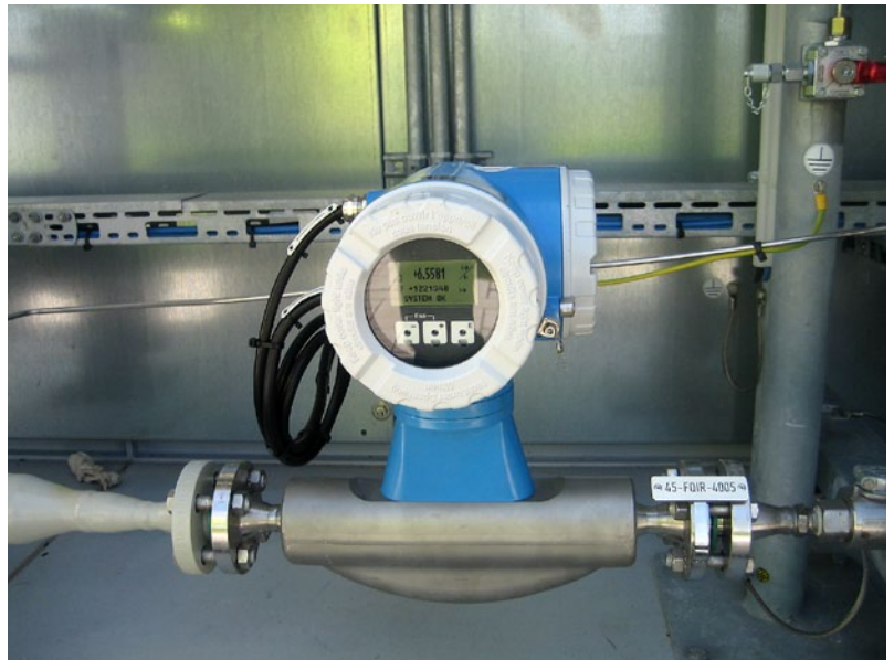
Bild 1. Proline Promass: kompakte Installation, ohne Ein- und Auslaufstrecken ermöglichen eine platzsparende und einfache Installation.
