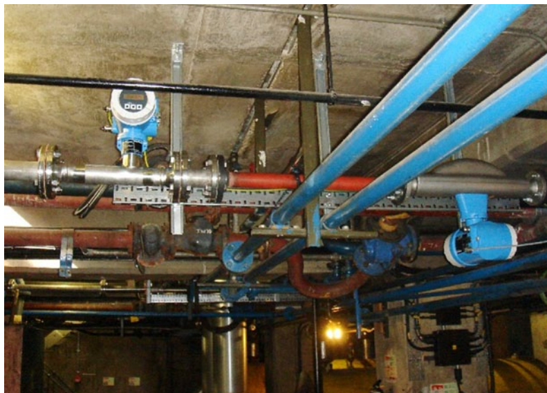
Messung von trockenem Biogas bei 3 bar mit einem thermischen Massemesser und einem Coriolis Massemesser.
