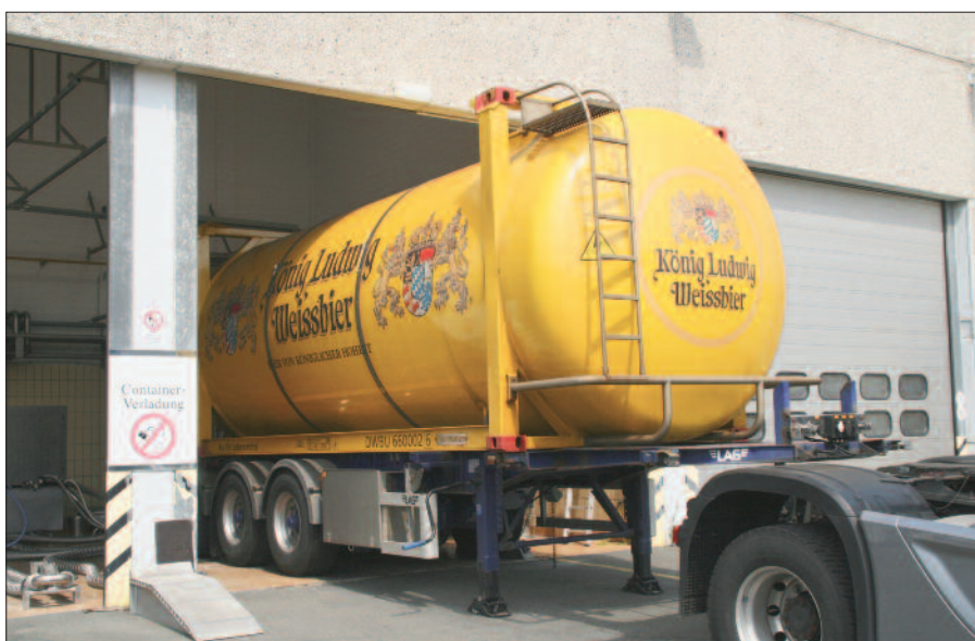
Tankaufleger beim Befüllen: eichfähige Verladeanlage entsprechend der neuen europäischen Messgeräte-richtlinie MID (Measurement Instrument Directive)
