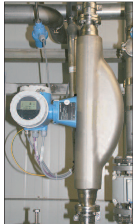
Massedurchflussmessgerät Proline Promass 84F: unbeeinflusst von Druck-, Temperatur-, Viskositätsschwankungen
