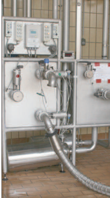
Anschluss- und Bedienpanel der Verladeanlage: Trockenlaufschutz durch Leermeldesonde ermöglicht Verzicht auf Gasabscheider. Befüllung nach dem „Vollschlauch-Prinzip“
