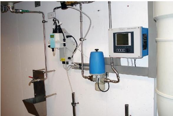
pH- und Trübungs-Messung im Wasserwerk zur Rohwasserüberwachung.
