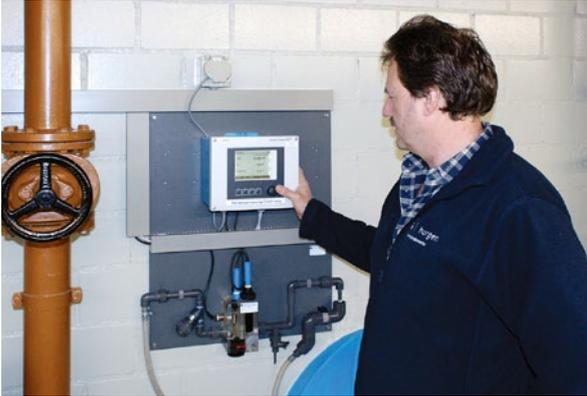
Mehrkanalmessumformer CM44x zur Anbindung von bis zu acht Analyse-Sensoren.
