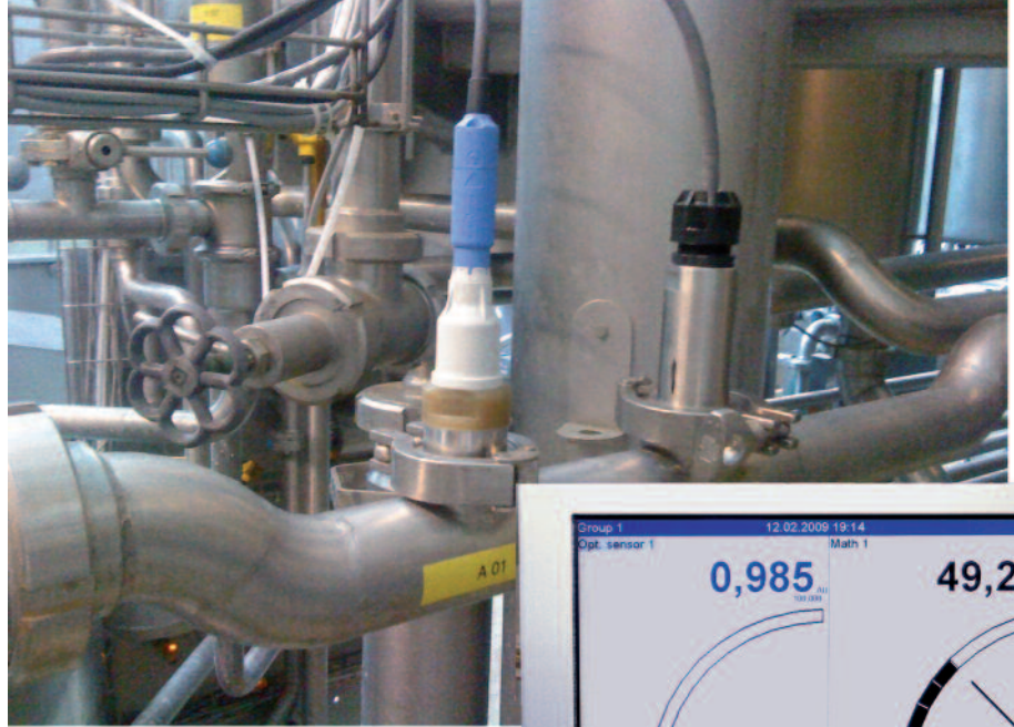
Abb. 2: Trübungssensor OUSA F11 zur schnellen Erkennung von Phasenwechsel und Leckagen
