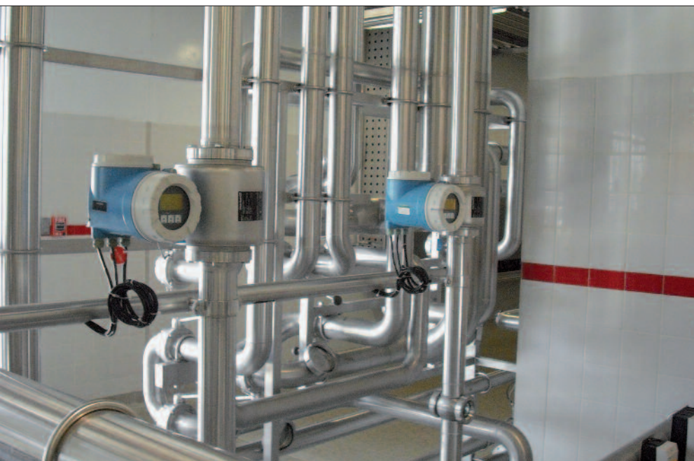
Abb. 1: Magnetisch-induktive Durchflusssensoren Promag H in optimaler, hygienischer Einbaulage
