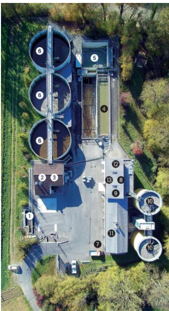
Fig. 1 : Vue aérienne de la station d'épuration de la région de Stetten avec la décantation primaire (4), le réservoir SBR (5), les trois réacteurs SBR (6) et la digestion anaérobie mésophile (10)
