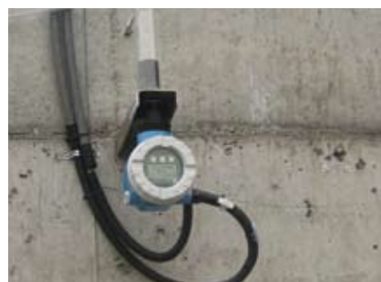
Füllstandmessung Gasspeicher (Nachfermenter) durch Positionserkennung des Pendels (Prosonic M)
