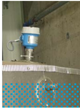
Grenzstand in der Hygienisierung: Liquiphant
