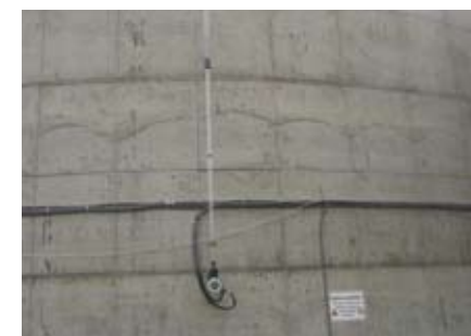
Füllstandmessung Gasspeicher (Nachfermenter) durch Positionserkennung des Pendels (Prosonic M)
