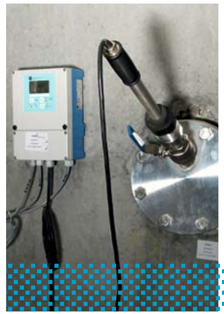
pH-Messung (links) und Feststoffmessung (rechts) mit Liquisys-Messumformer, Sensoren und Prozessarmatur
